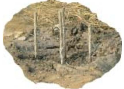
土台となる穴を12カ所空け、この土台を元に高さ1mの枠を作りコンクリートで埋めて基礎となります。土地が低いので、土を入れ込んで土地を同高さにします。
