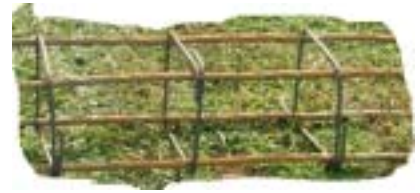
土台用15 mm鉄筋使用。
